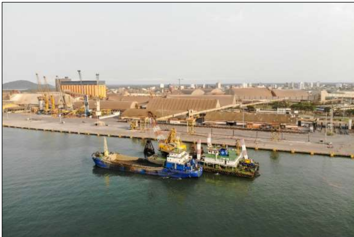
Figura 22 - Dragagem de manutenção por clamshell realizada na APPA (vista aérea)
