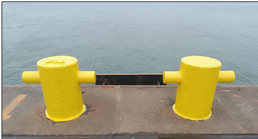
Figura 2: Cabeço de Pilar Duplo (double bitt bollard).
