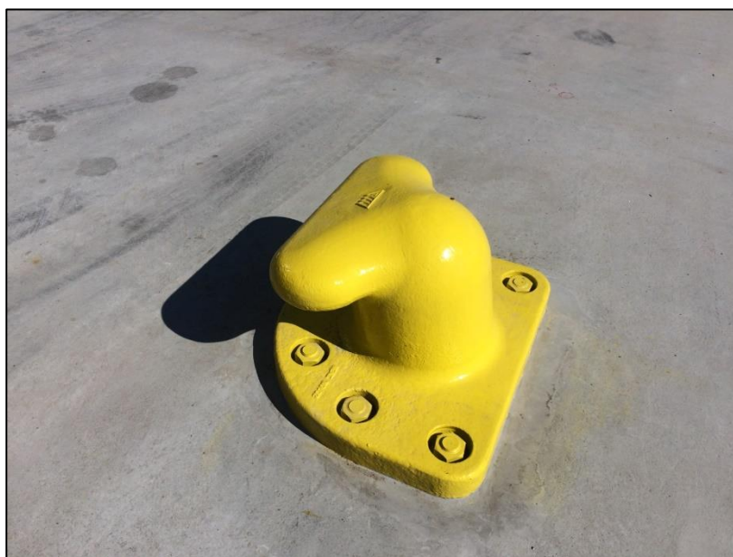
Figura 3: Cabeço-T (tee bollard).
