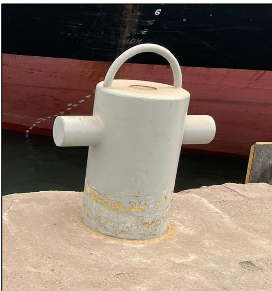
Figura 1: Cabeço de Pilar Simples (single bitt bollard).
