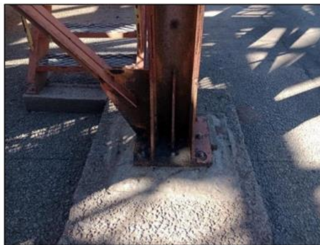
Imagem 06 e 07 – Bases de concreto das torres.
