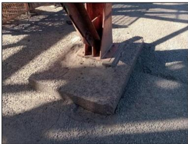
Imagem 06 e 07 – Bases de concreto das torres.
