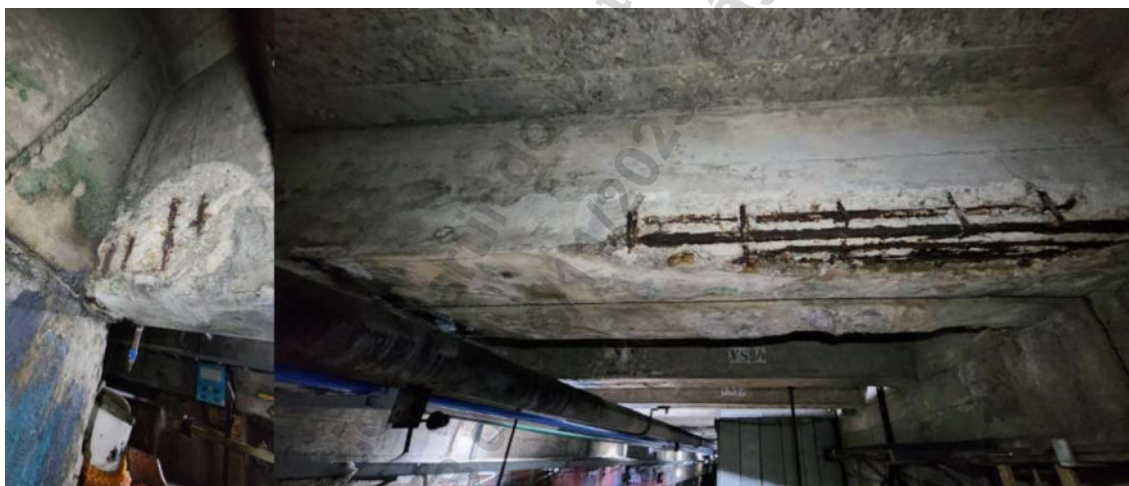
Figura 2: Imagens de algumas patologias encontradas nas estruturas.
