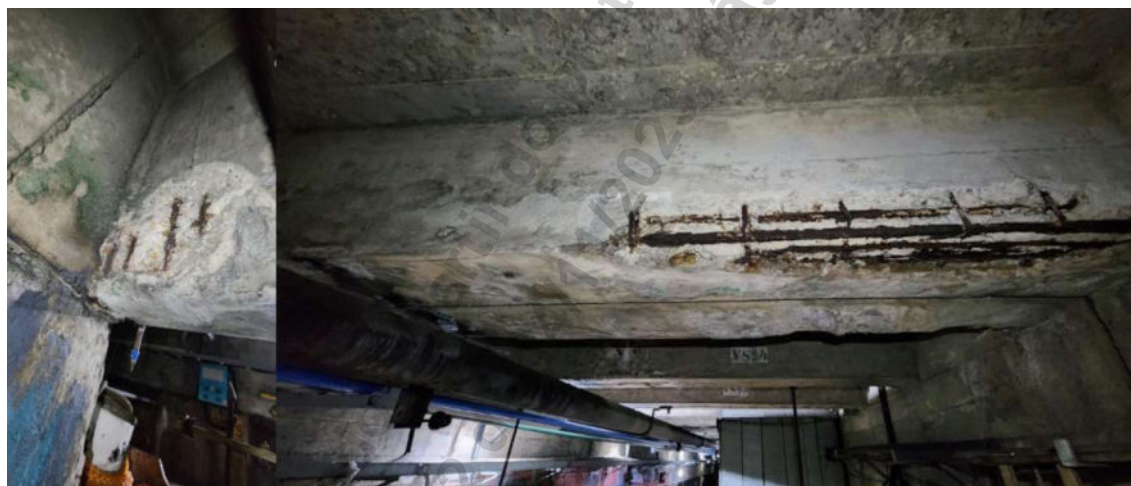
Figura 2: Imagens de algumas patologias encontradas nas estruturas.
