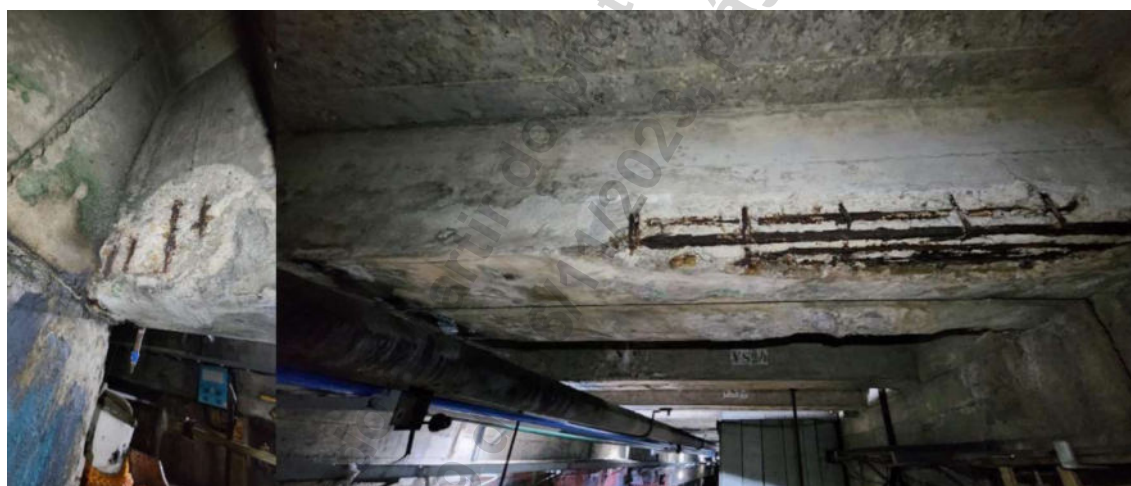
Figura 2: Imagens de algumas patologias encontradas nas estruturas.
