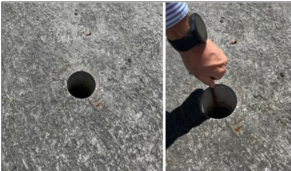
Figura 2 - Furo de inspeção realizados em 2023 no berço 205 da Portos do Paraná.
