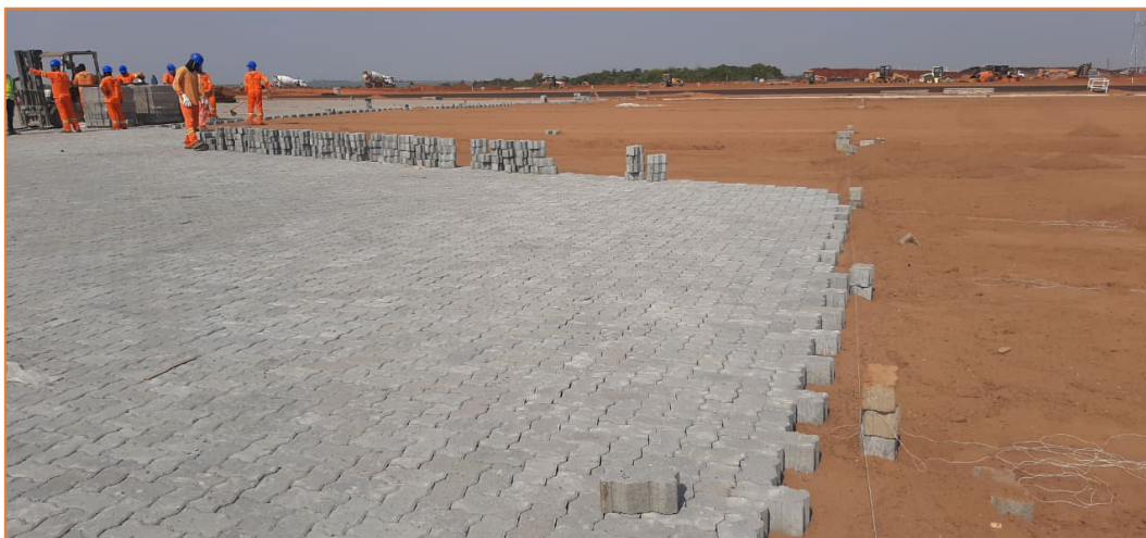
Figura 6 – Aplicação de bloco articulado intertravado de concreto
