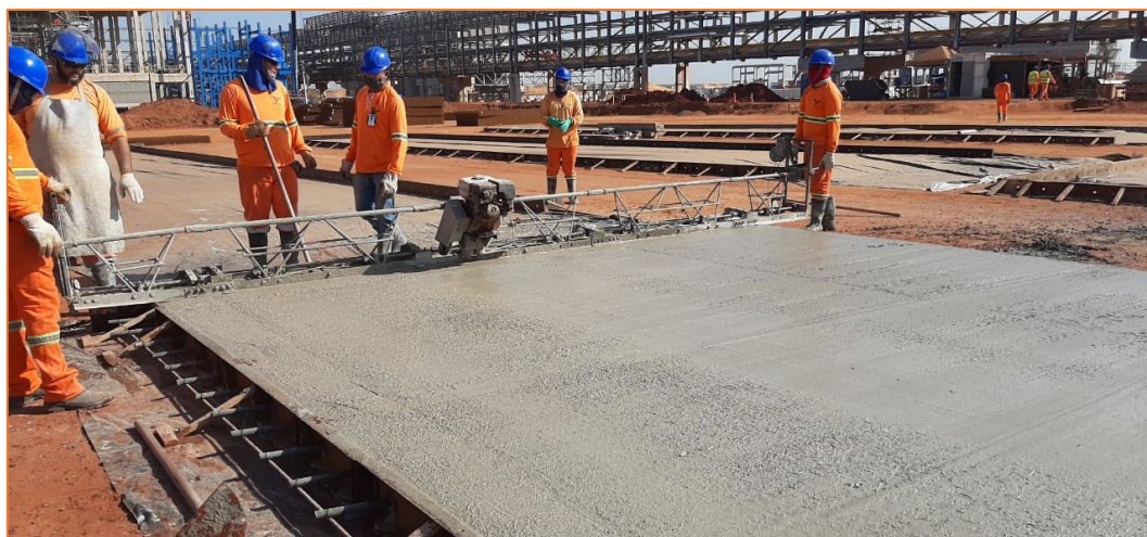
Figura 5 - Concretagem do piso armado
