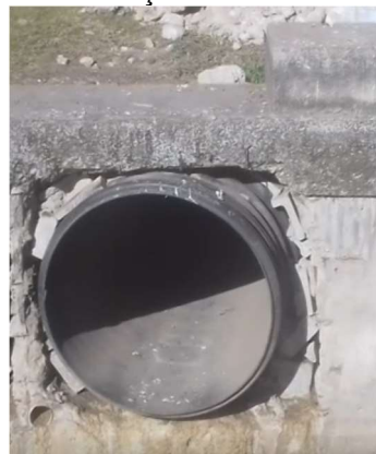
Figura 19 - Interferências com postes, meios-fios, canaletas, árvore e tubulações
